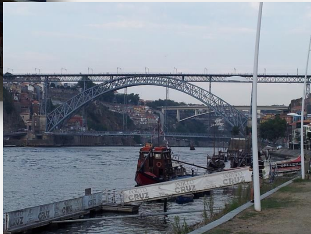
Brücke über den Rio Douro
